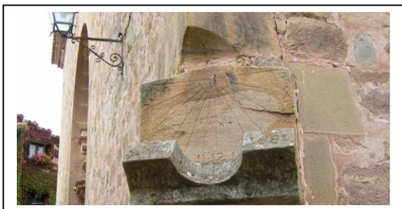
**RELOJ DE SOL.-** Fechado en 1681. Acoplado en el cantón derecho de la fachada de la Iglesia parroquial sobresaliendo del ángulo de la esquina. De piedra de arena, es uno de los mejores ejemplos en Aragón de los relojes polares simples, conserva la varilla de un solo apoyo y lleva las horas numeradas en arábigos. Figuran los nombres del cantero que lo labró “Iaqobvs Pérez avtor” y del que calculó el reloj “El Prat me fecit”. Con una inscripción en la cara inferior que indica: “AVE MARIA”.
